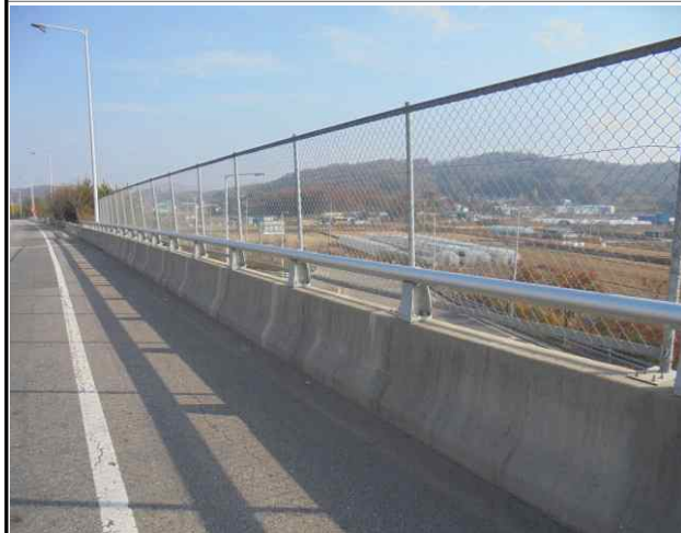
난간 및 연석 전경
